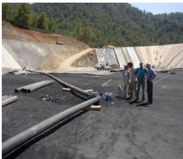
Figura 5-10: Constructia unui depozit de deseuri
