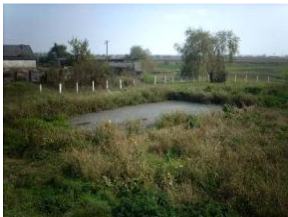
Figura Nr. 2-24 – Guri de canalizare
