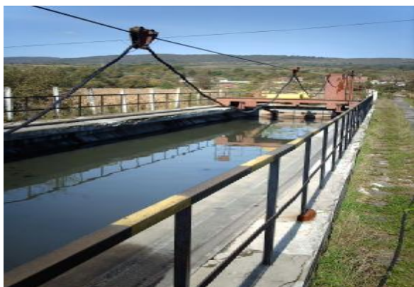
Figura Nr. 2-40 – Rezervorul de sedimentare
