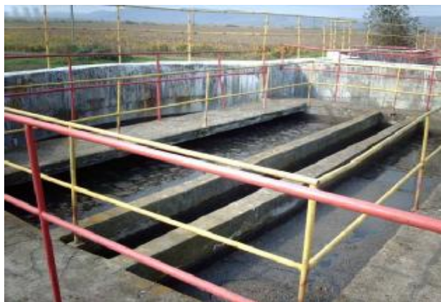
Figura Nr. 2-23 – Bazine de sedimentare
