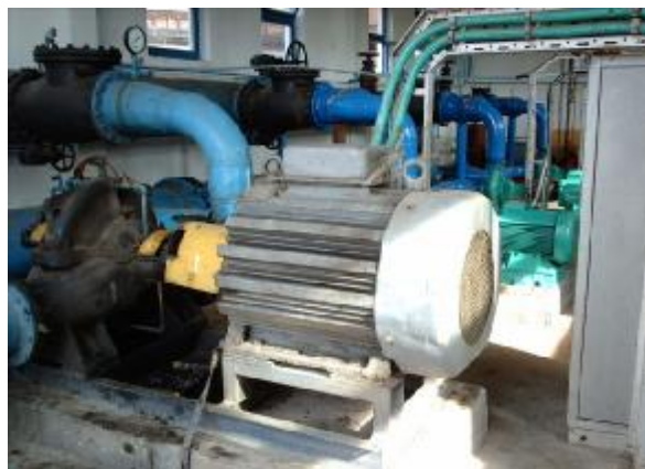
Figura Nr. 2-43 – Pompele de distribuție
