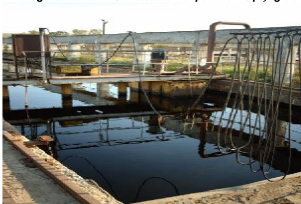
Figura Nr. 2-13 – Bazinul primar de sedimentare sedimentare
