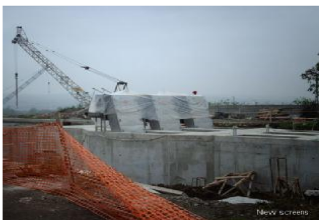
Figura Nr. 2-29 – Stația de tratare ape uzate – Gratare noi
