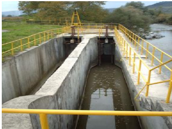
Figura Nr. 2-3 – Stația de tratare a apei Sighișoara – Unitățile de îndepărtare a nisipului
