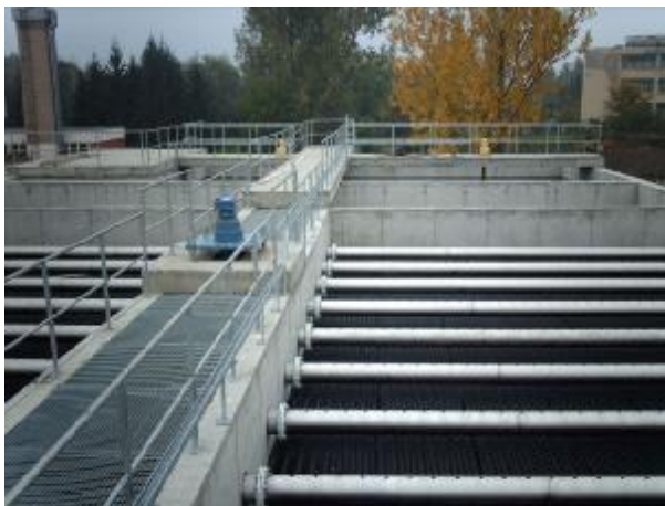
Figura Nr. 2-25 – Bazine de sedimentare noi
