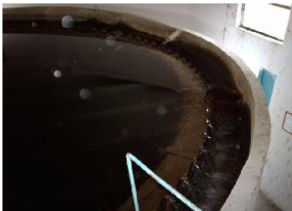
Figura Nr. 2-42 – Camera de amestec și distribuție
